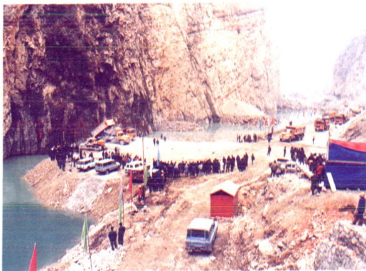
东风电站施工现场
