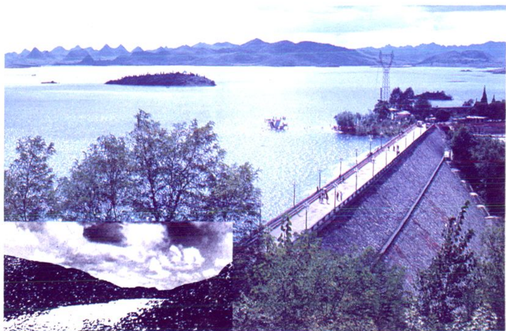
红枫电站拦河大坝及其旧址
