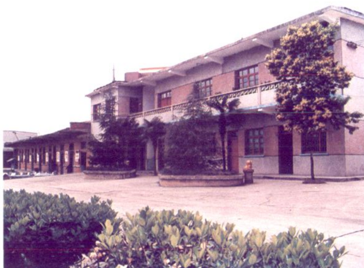
检修队办公楼
