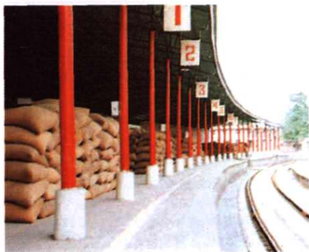
石家庄市第二粮库铁路 专用线货台。
