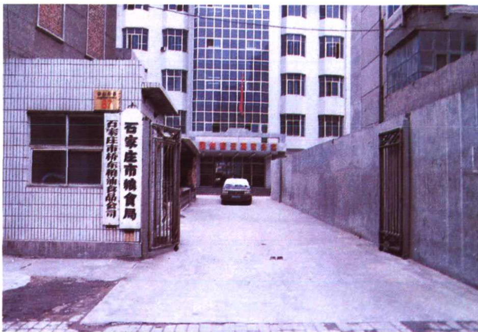
石家庄市粮食局办公楼(正面)。
