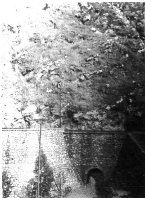
中华民国时期的1号机组锅炉交通洞洞口。
