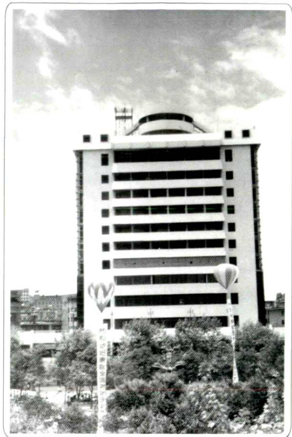
凯里民贸大楼
