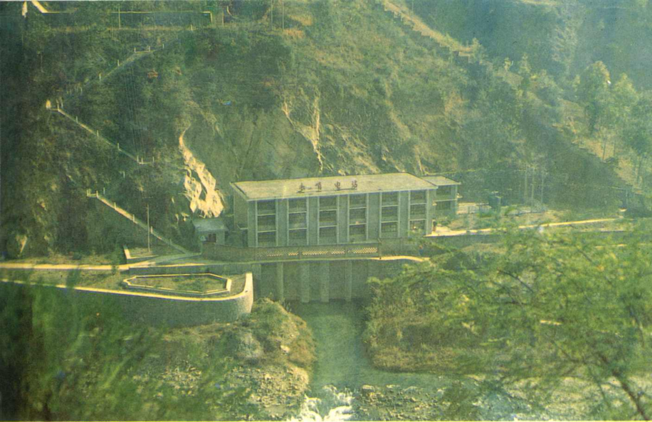
镇安县长哨电站
