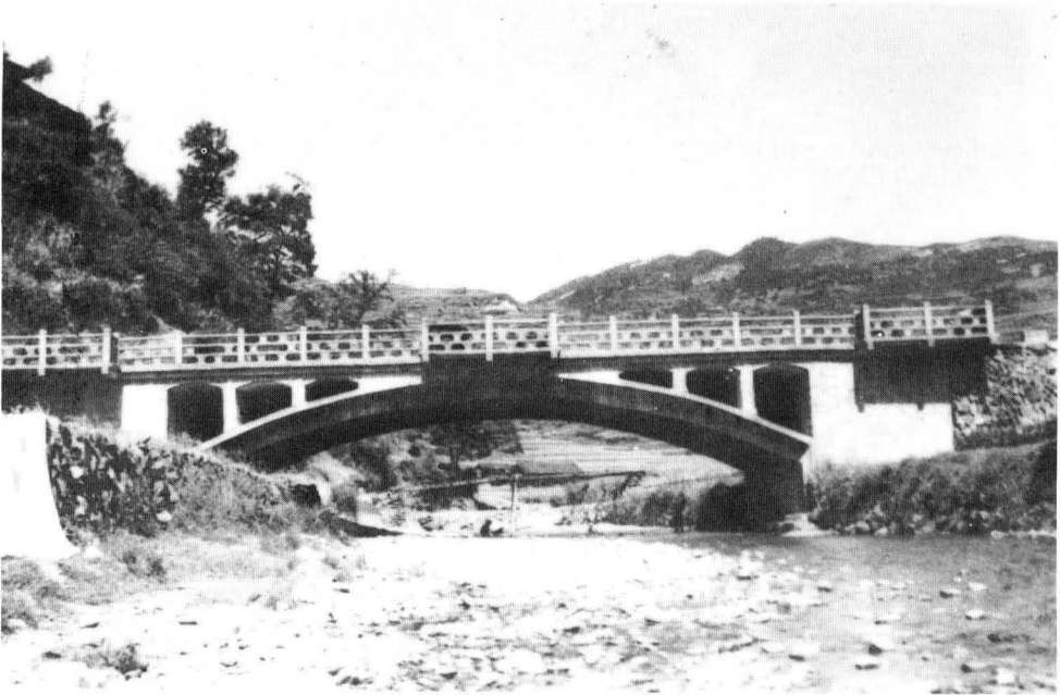
雷山—西江公路西江桥，为单孔跨径20米的双曲拱桥，全长30延米。建于1981年。
