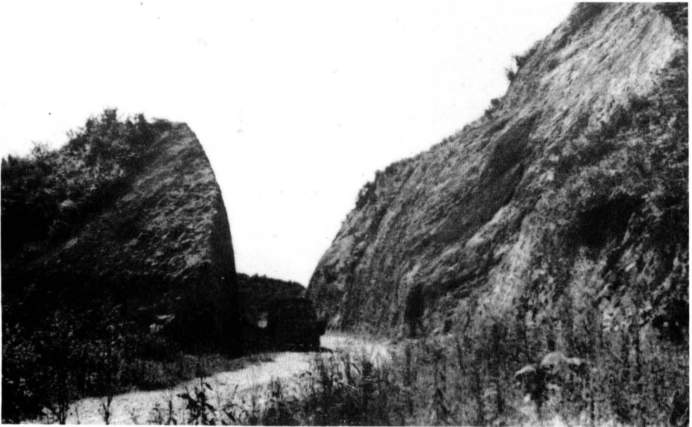
雷山—舟溪公路续建中的往报坡大拉槽
