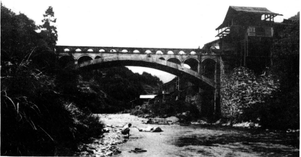
塔石—达地公路塔石桥，为单孔跨径28.7米的双曲拱桥，全长40延米。建于1973年。
