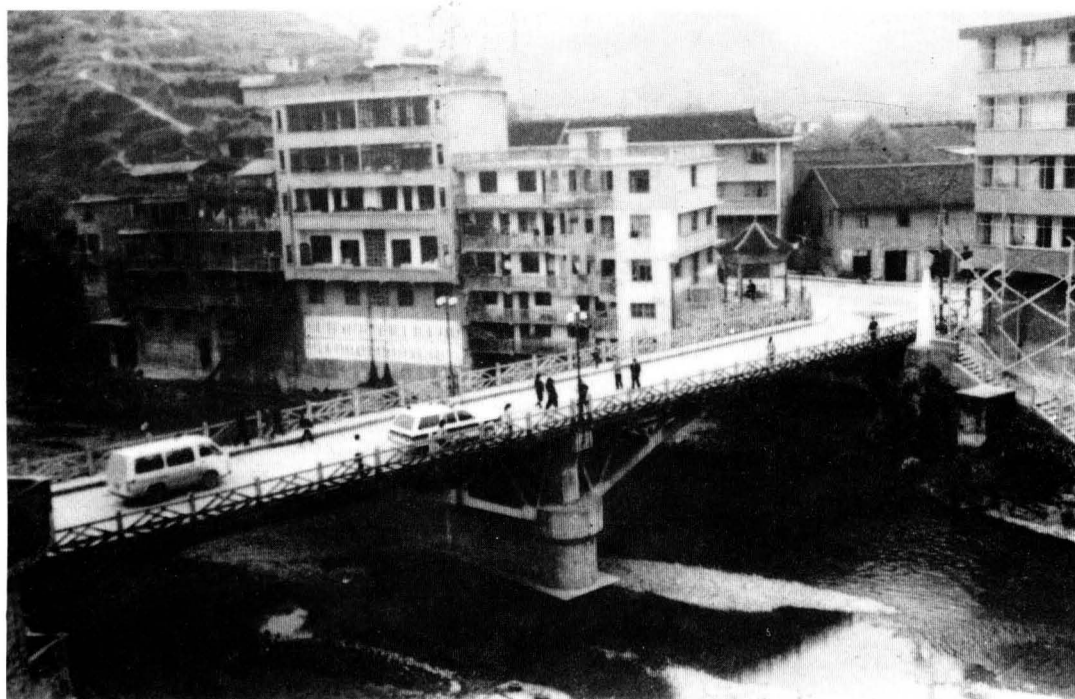
雷山—西江公路雷山桥，为2孔跨径25米的钢筋混凝土桁架拱桥，全长68.5延米。建于1986年。
