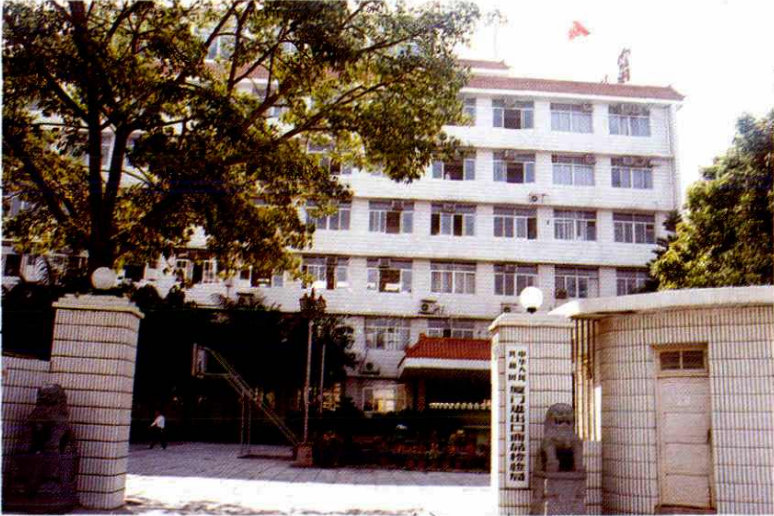
厦门商检局检验办公大楼
