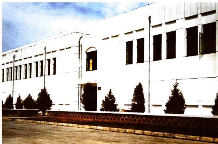
1995年建成的怀来县河北龙泉葡萄发酵有限公司厂区新貌
