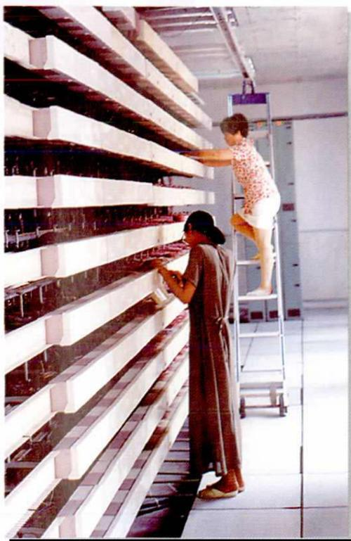
图为1995年10月7日开通的万门程控交换机配线架
