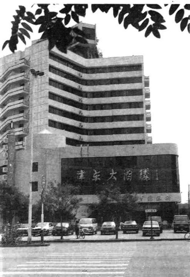
▼津东饭店——津东大酒楼
