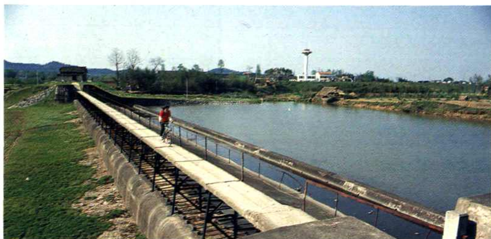
南湖滚坝 进水闸
