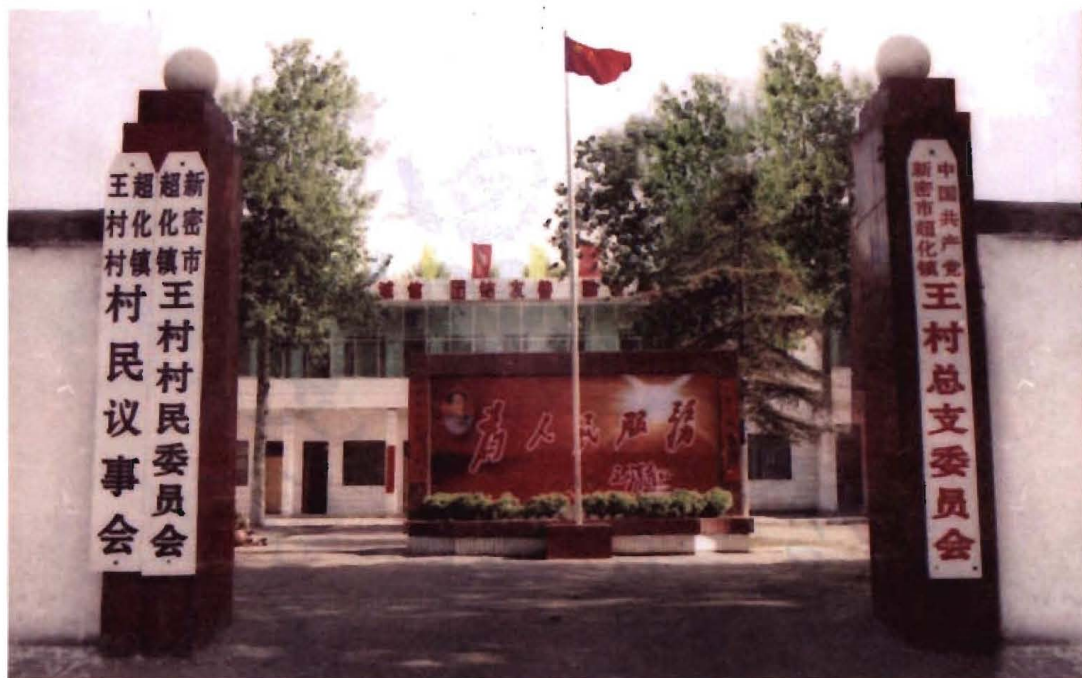
王村村党总支、村委会办公楼
