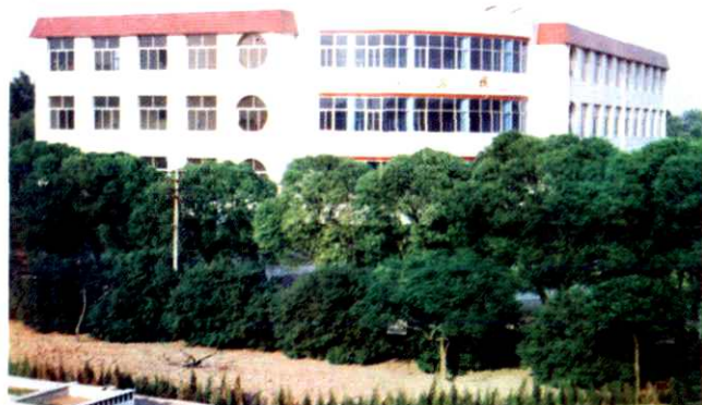
忻州地区原平农业学校实验楼
