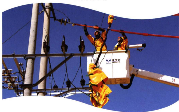
10kV配网带电作业
