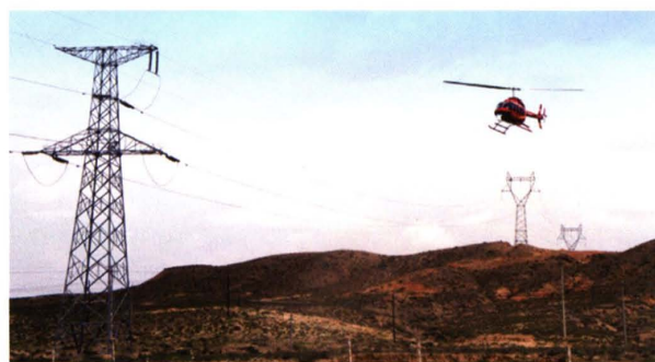
2006年以来直升机巡检业务成为保证电网安全生产的重要手段
