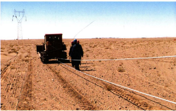
2004年, 吉贺线220kV输变电工程施工现场
