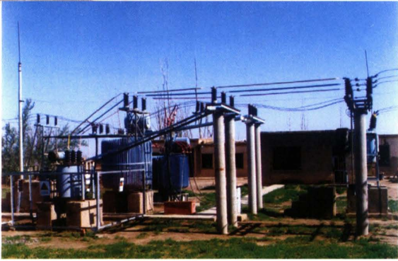
70年代建成的35kV格林滩变电站
