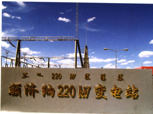
2005年6月29日, 220kV额济纳变电站建成投运, 宣告蒙西电网覆盖阿拉善盟全境
