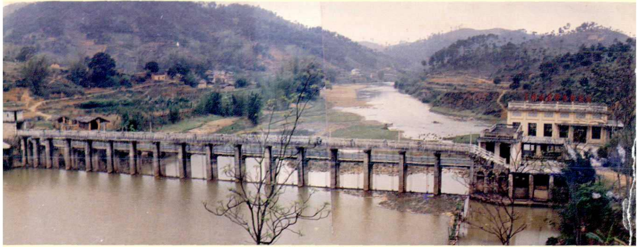
全党水轮泵站拦河坝
