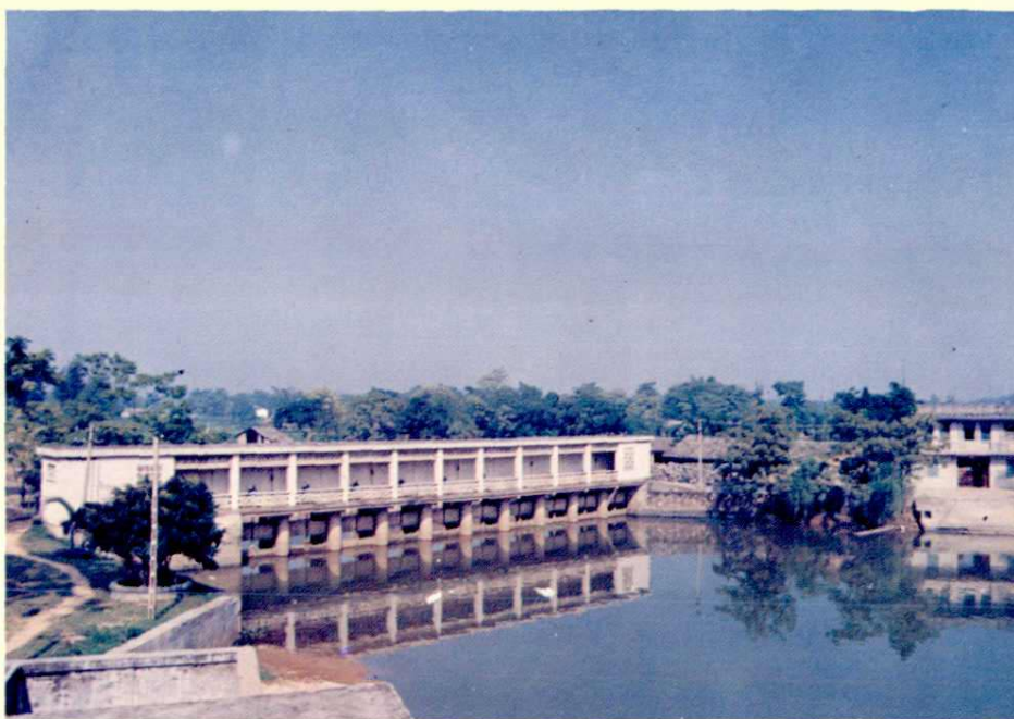
玉林城区排洪闸
