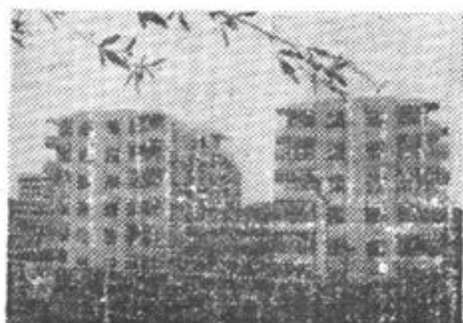
↑ 开封市一建公司永安街建工公寓
