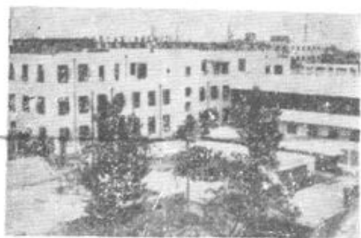
→ 开封市一建公司机关大院
