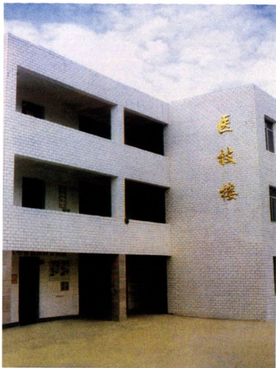
弥陀卫生院医技楼
