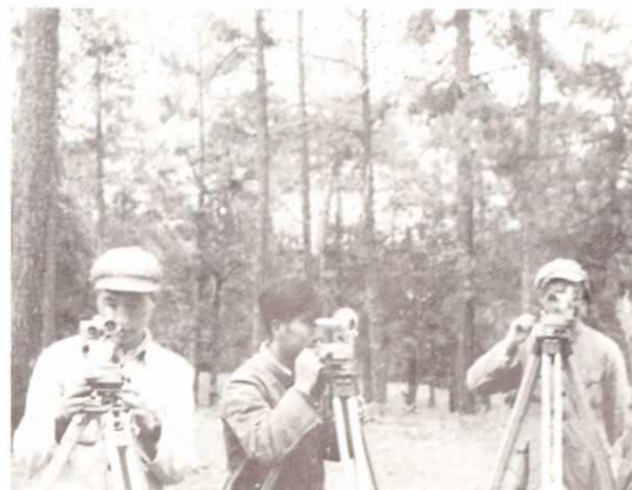
定期进行测量仪器的检查校正
