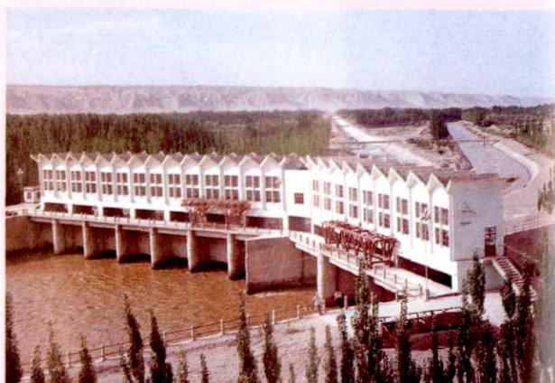
卡群水利枢纽泄洪闸
