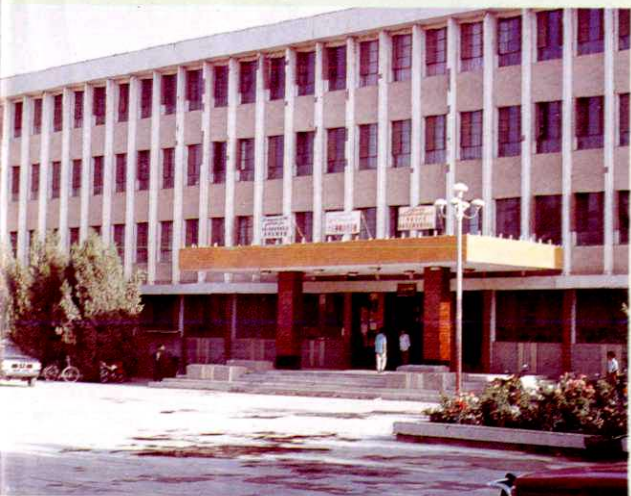
中共莎车县委员会办公楼
