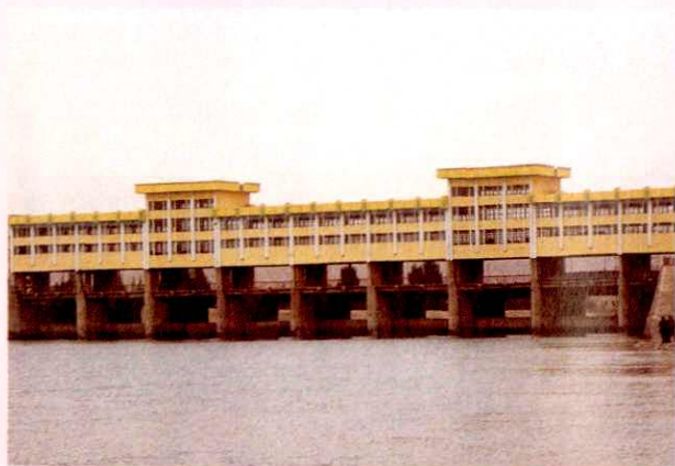
叶尔羌河上卡群水利枢纽——西岸分水闸。
