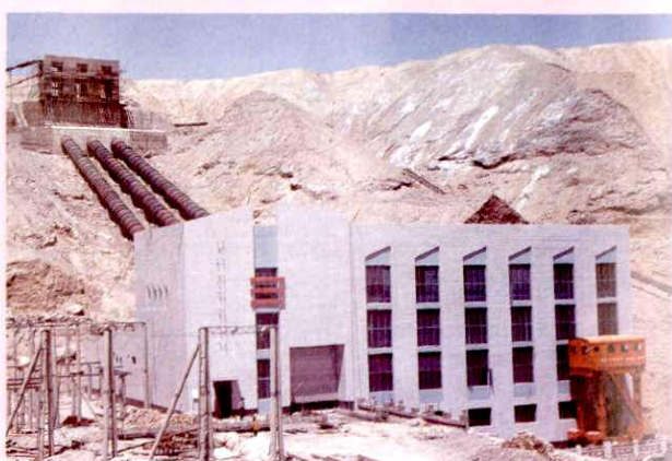
建设中的卡群一级电站
