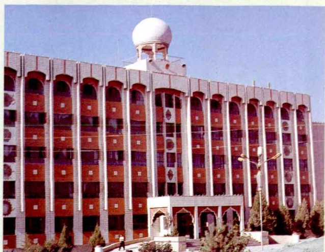
莎车县人民政府办公楼
