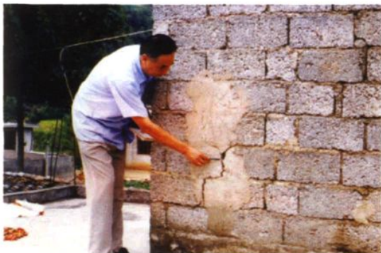
高桥 M L 3.6级地震时,震中区陈兴良、李读文等人住房墙体开裂
