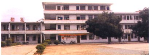
通门镇初级中学教学楼
