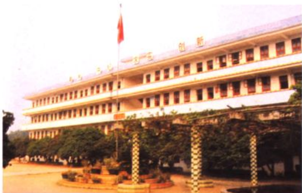
桂圩镇初级中学教学楼
