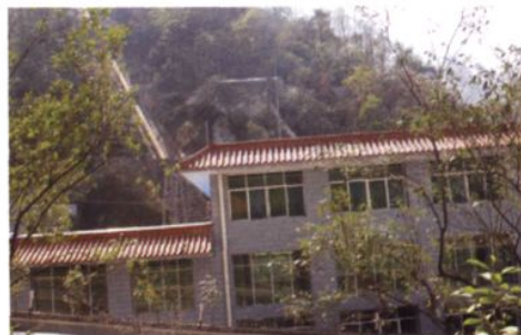
装机10000千瓦的龚家沟电站
