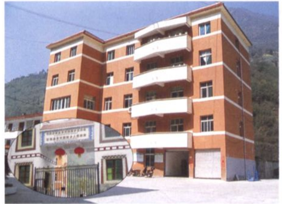
乡政府新办公大楼
