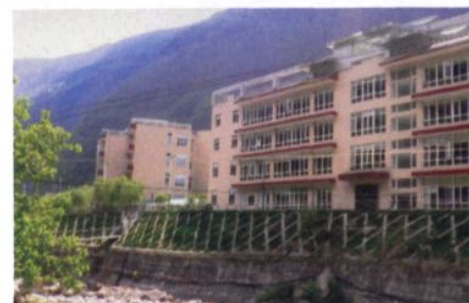
川投公司在草科新建的办公大楼
