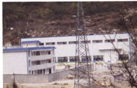
装机21000千瓦的喇嘛沟电站
