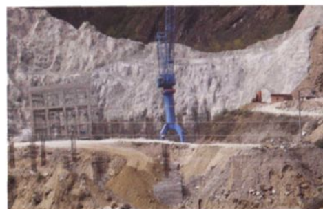
正在修建的川投金窝电站
