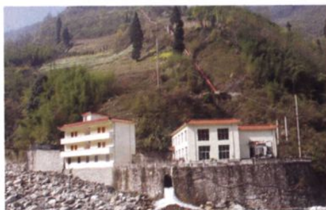
装机1200千瓦的大泥一级电站
