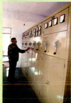
建设中的煤矿标准化设施
