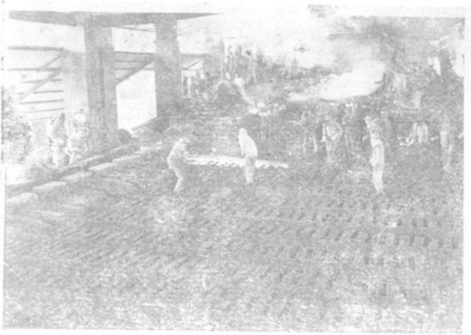
炉前沙模铸铁
