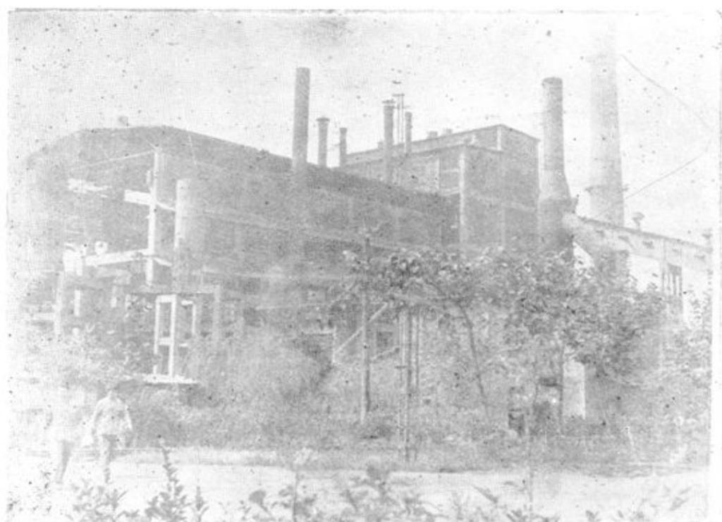
年产20余万吨烧结矿的24M<sup>2</sup>烧结机外景
