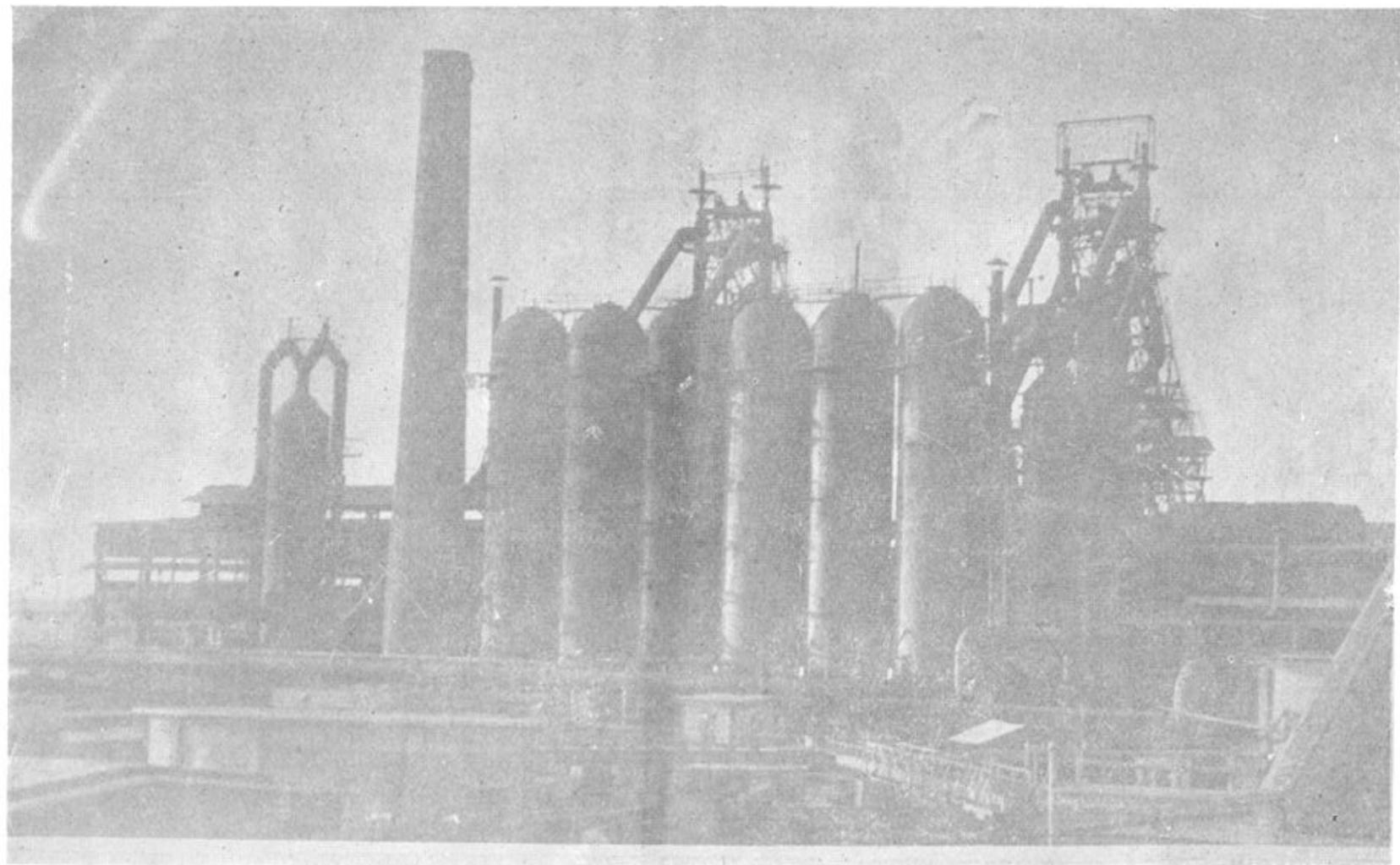
年产30余万吨生铁的杭钢炼铁高炉雄姿
