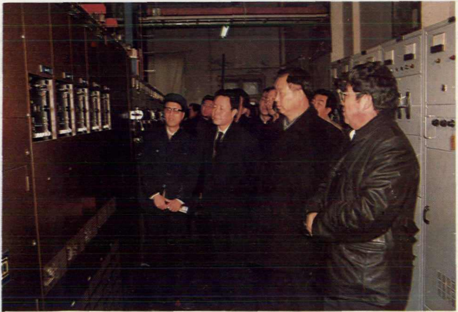
行署专员张士英（前右二）陪同省邮电管理局基建处副处长朱维忠（前左一）视察地区邮电局电力室。前左二为地委秘书长田结实，前右一为地区邮电局局长李宗。
