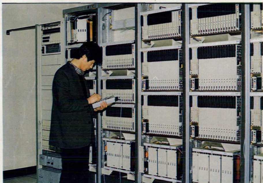
长途电话、市内电话合一的程控空分数字自动交换机
