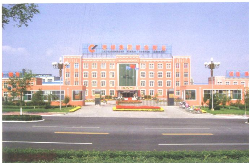
新泰铜业公司办公大楼
