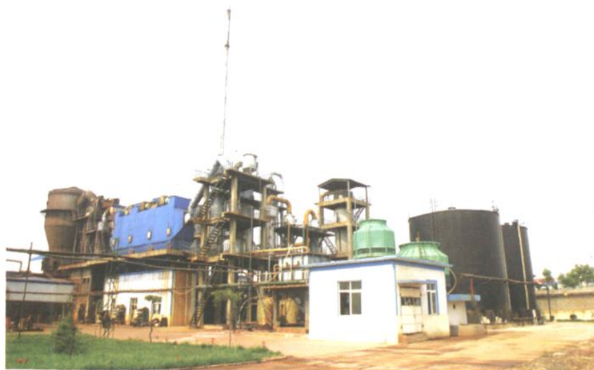
硫酸铜厂沸腾焙烧炉系统外貌
