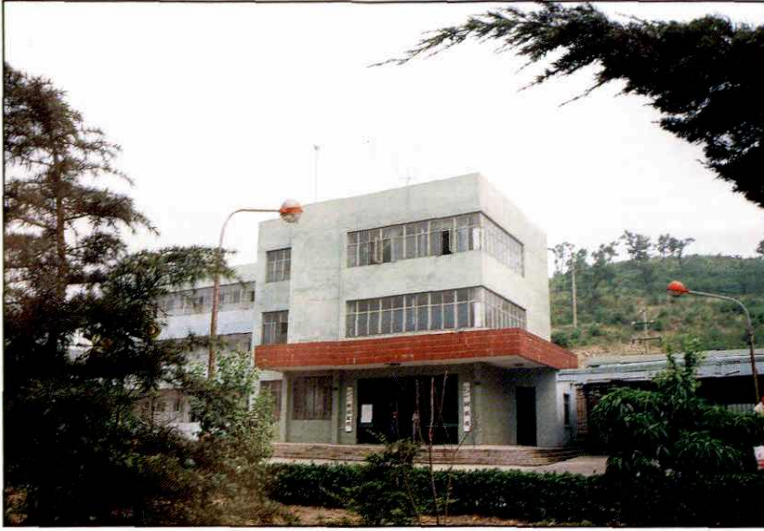
机修车间办公楼
