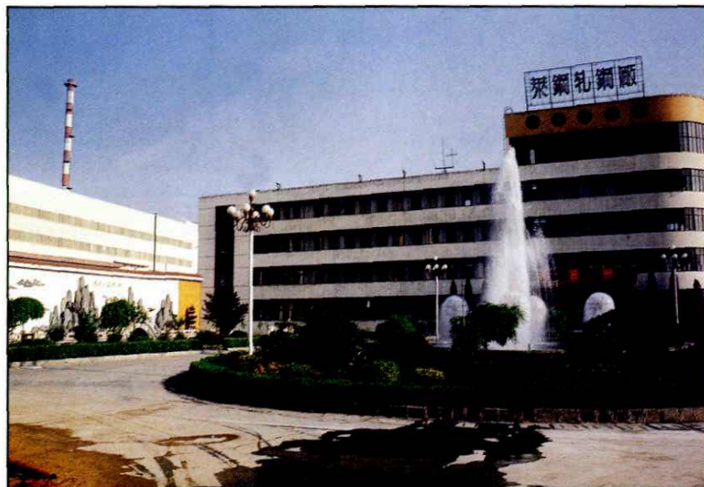
轧钢厂办公大楼
