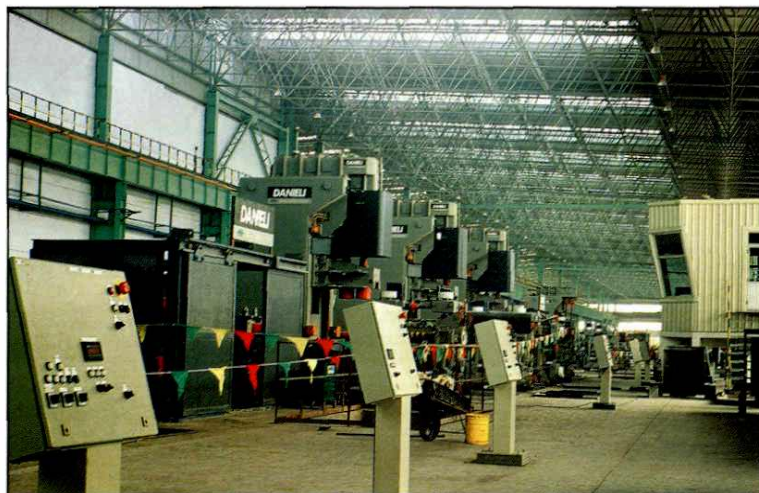
中小型车间设备安装完毕
