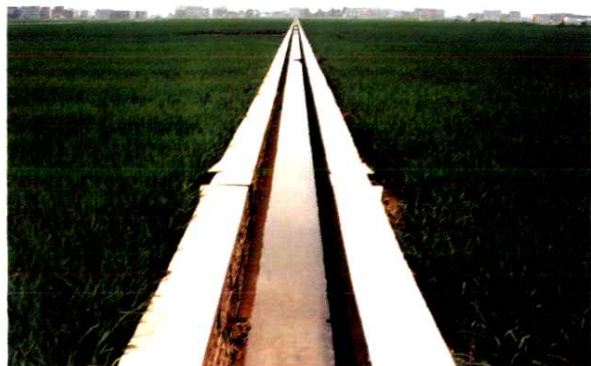
农业园区三面光渠道
