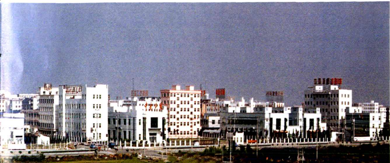
龙港印刷示范工业园区一期工程全景
