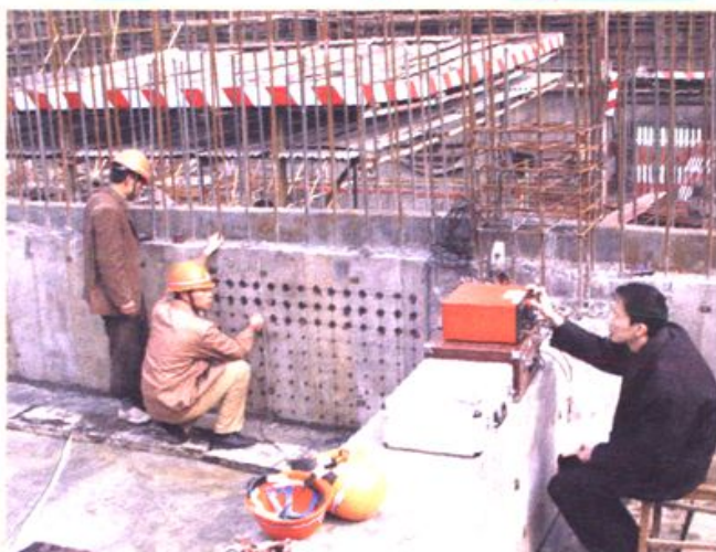
● 检测人员正在对某工程进行测缺
