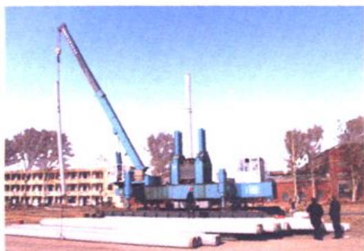
● 压桩机施工现场
