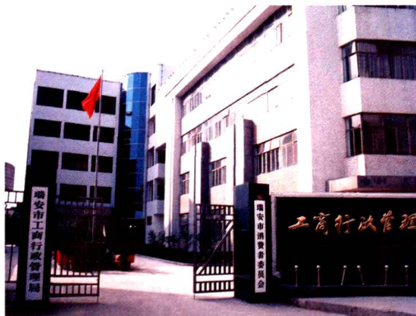
▲ 瑞安市工商行政管理局原办公大楼
