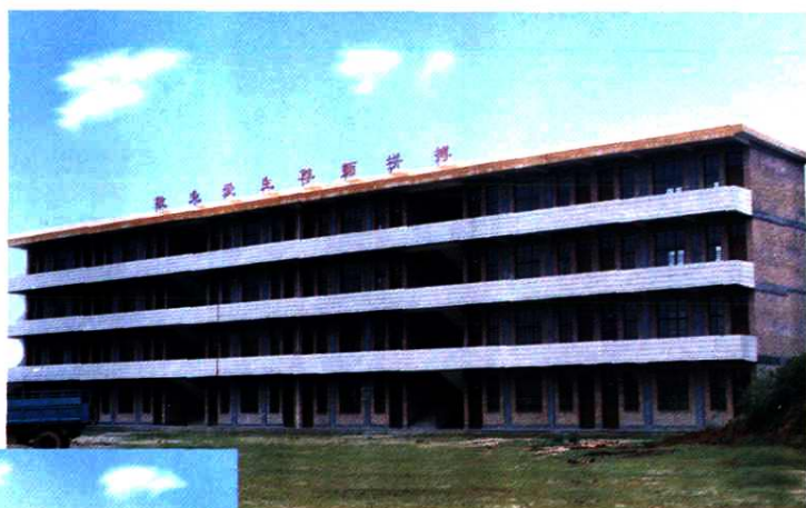
水头中学教学大楼
