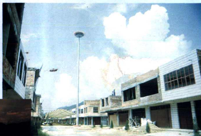
禾溪埠新圩高杆灯
