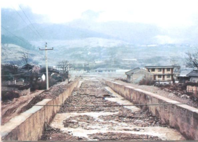
治理后的维西县城二道河。图为排导槽
