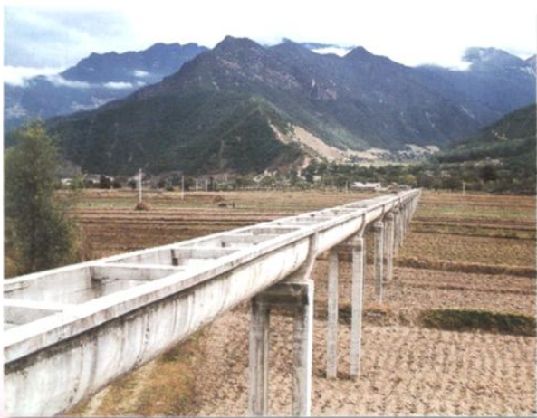
金沙江提灌工程之一，香格里拉县上江仕旺提灌站渡槽
