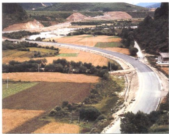
新改建成的国道 214 线二级油路
