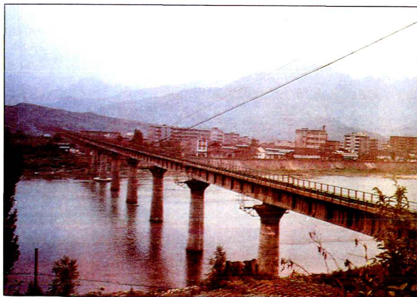
四处承建的广罗铁路上横跨滔滔东河、连结旺苍新城老城,全长1071.15米的东河特大桥。
