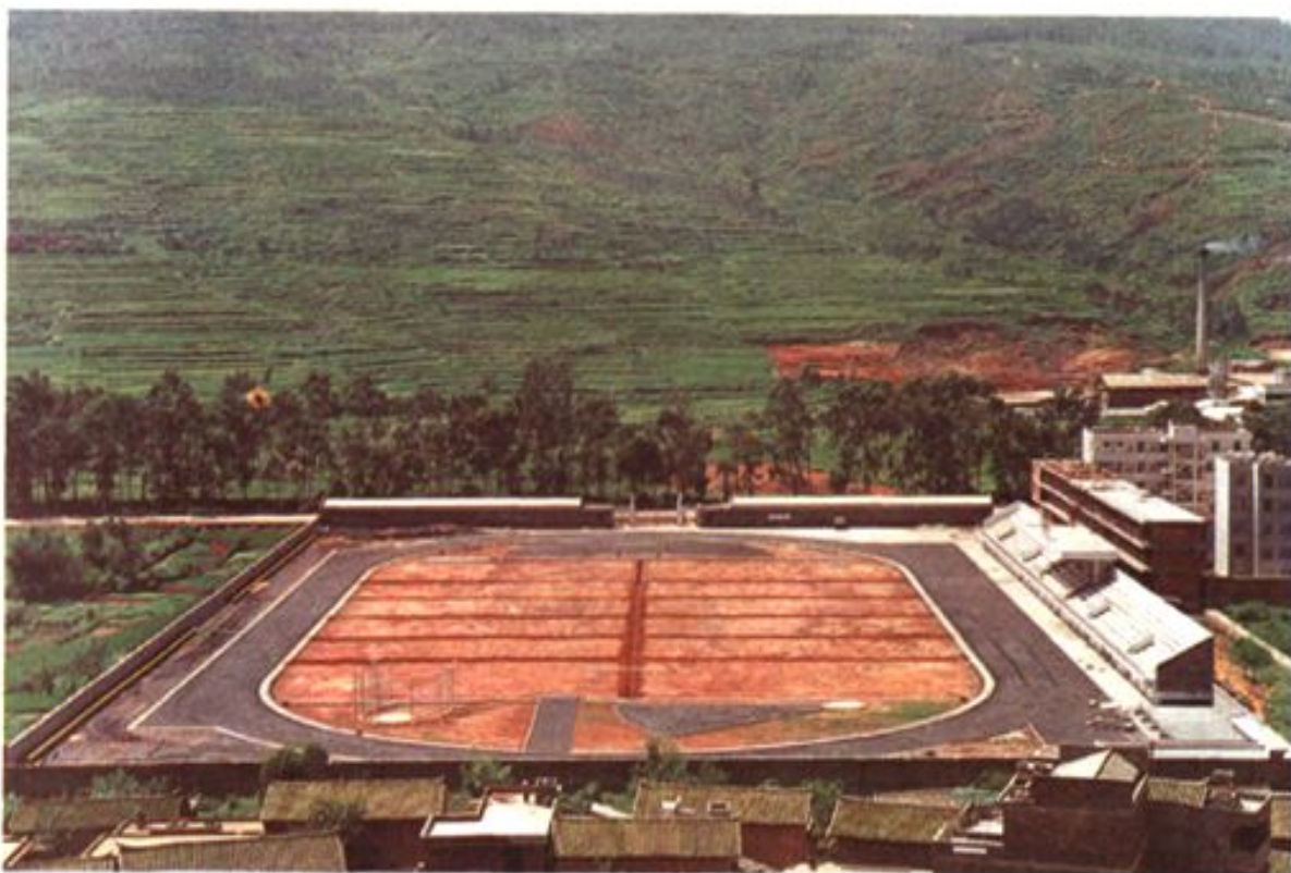
▲1988至1995年，全县共审批国家建设用地6990.79亩。图为占地面积达31.35亩的县城体育中心田径场。
