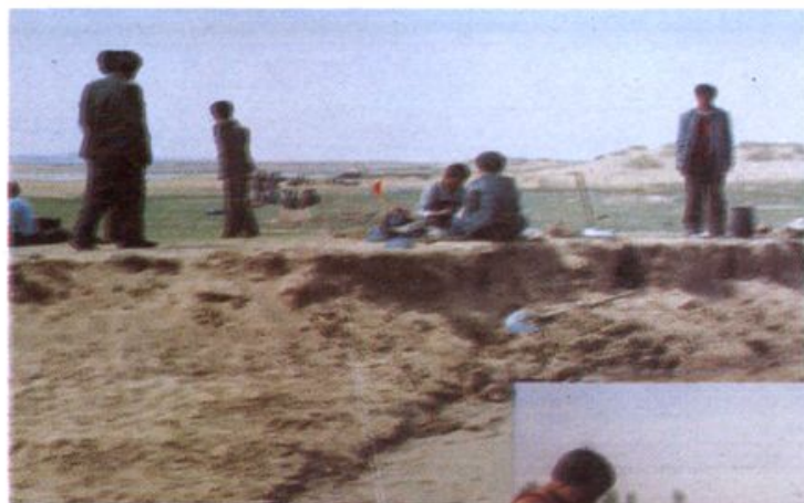
公路建设工地
