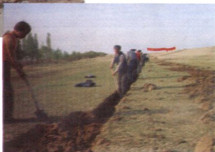
苏木公路建设
