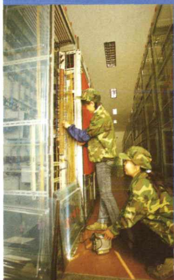
继电二次回路绝缘测定
