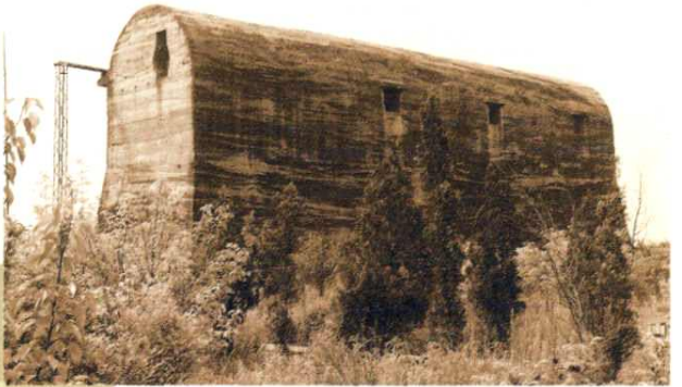
日伪时期李石寨变电所主变防弹壁
