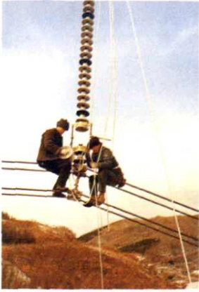
500 千伏丰辽线带电更换瓷瓶
