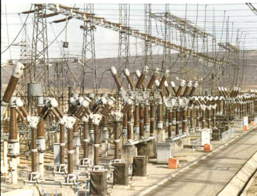
李石寨变电所 220 千伏开关设备
