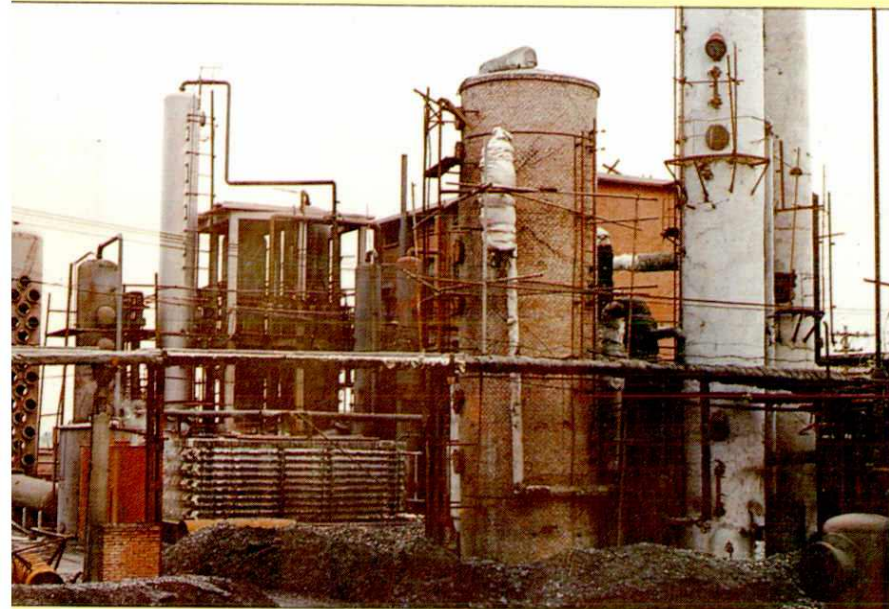
化肥厂合成塔
