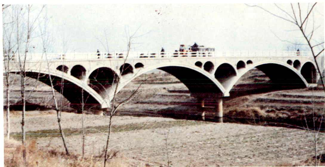
小清河岔河大桥
