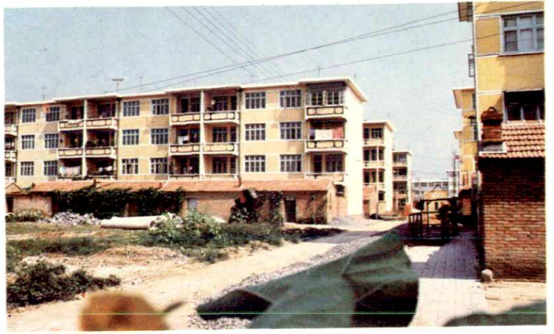
县城新建居民区楼群一角
