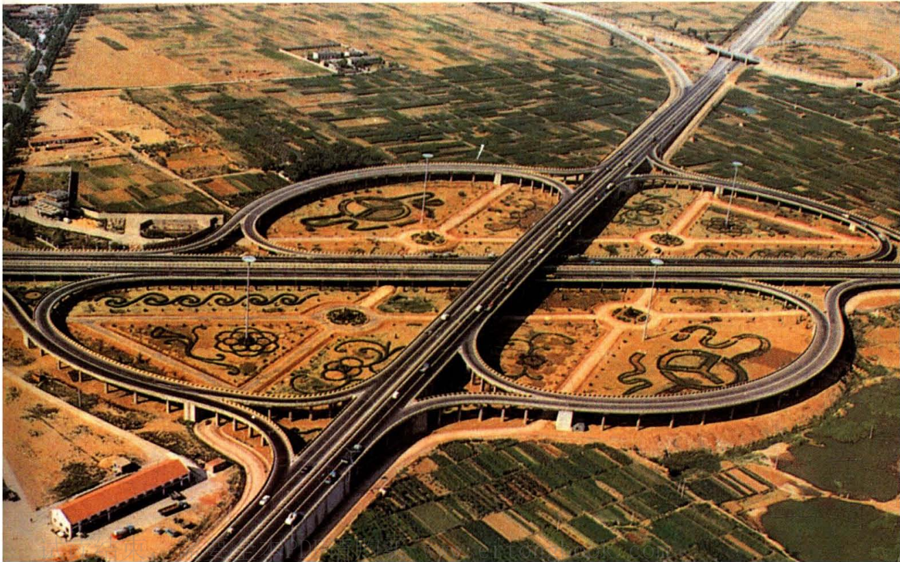
青岛市流亭公路与公路立体交叉
