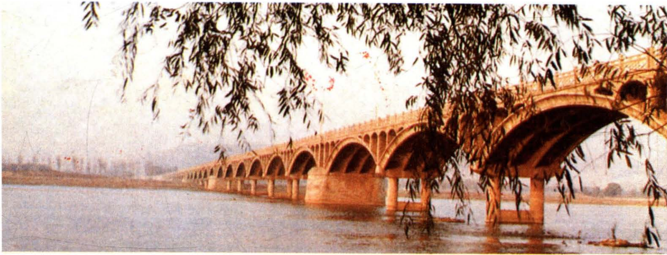
平阴—徐州公路东平流泽双曲拱桥
