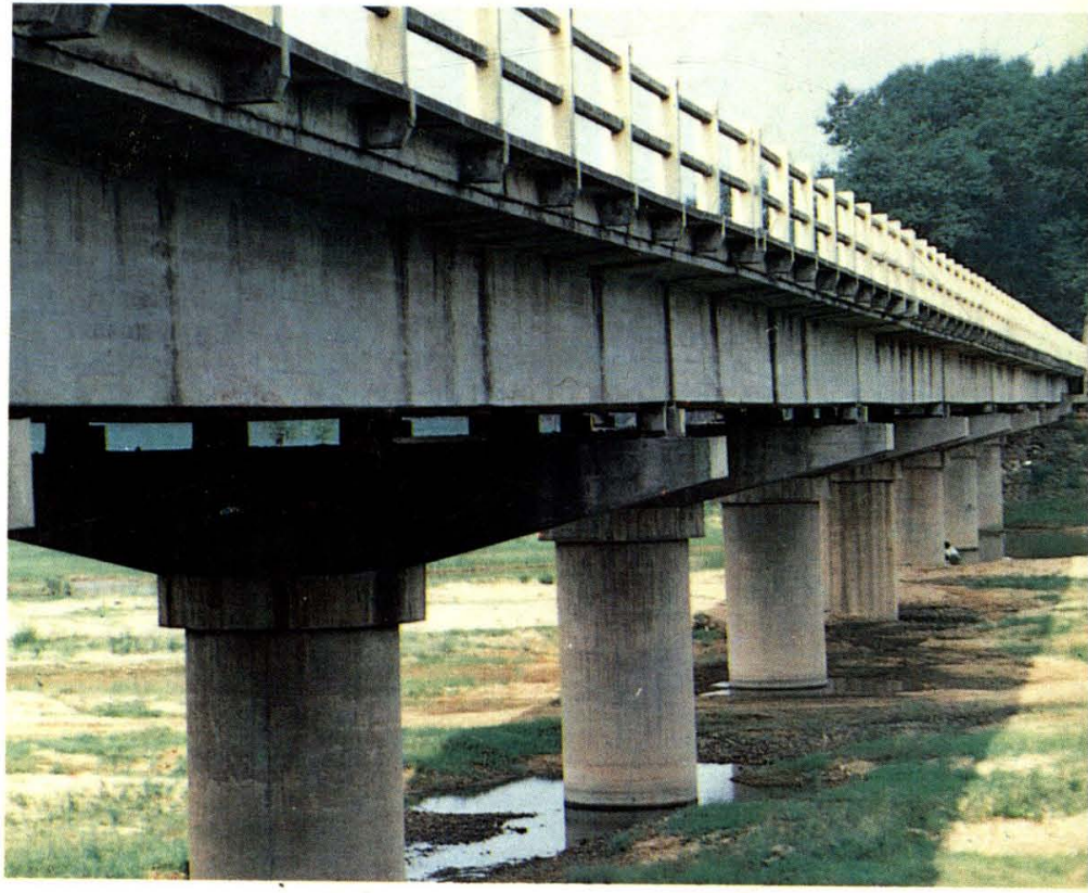
潍坊—荣成公路泊子庄单圆柱墩钢筋混凝土T型梁桥
