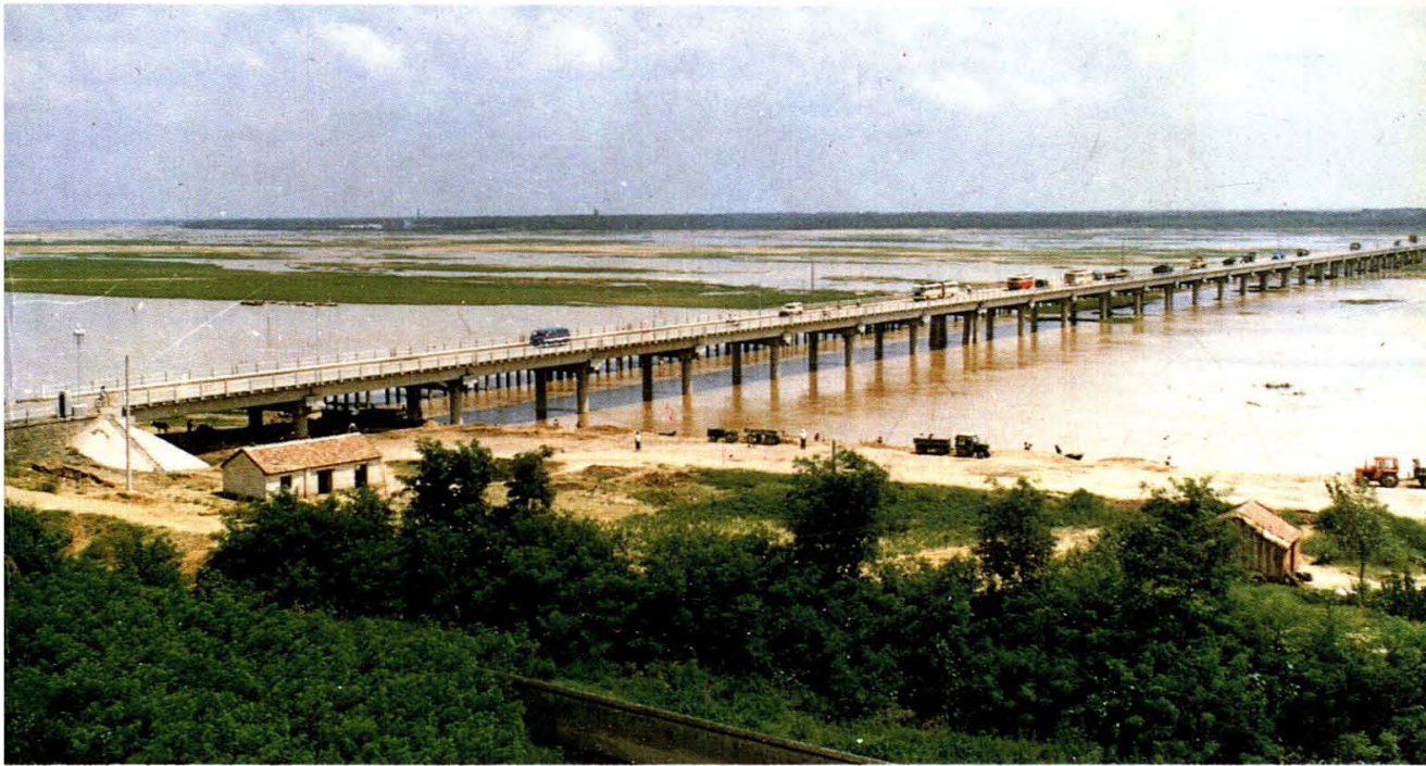
岚山头—兖州公路临沂沂河钢筋混凝土T型梁桥
