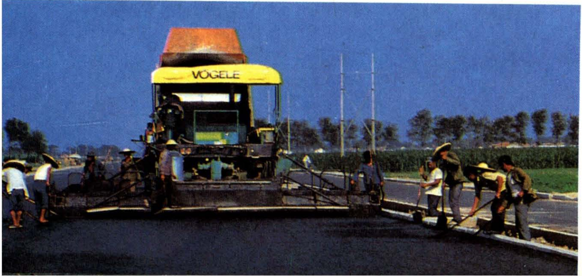
沥青混凝土路面面层摊铺
