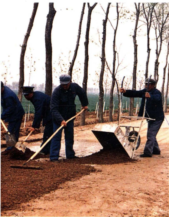
铺筑路面磨耗层
