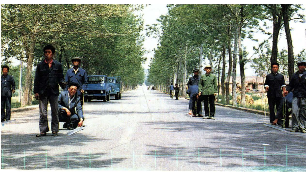
用直尺量验路面平整度
