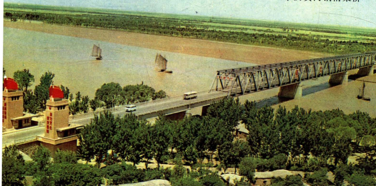
平阴黄河钢桁架桥
