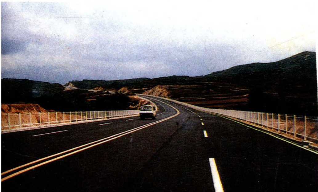
青岛—威海省 道九里水头江 家寨段汽车专 用二级路
