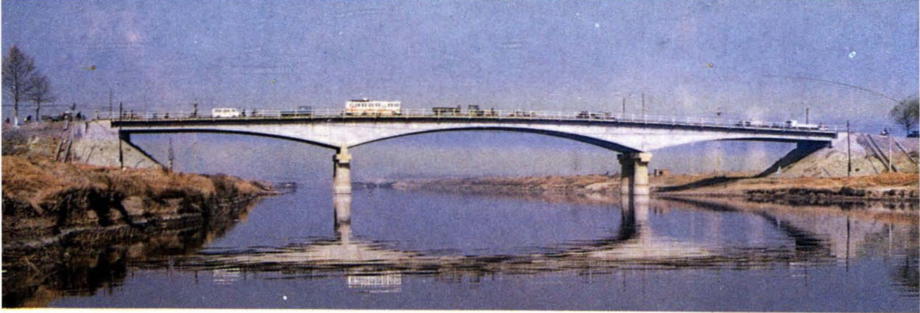
兖州—兰考公路济宁京杭运河变截面钢筋混凝土连续梁桥
