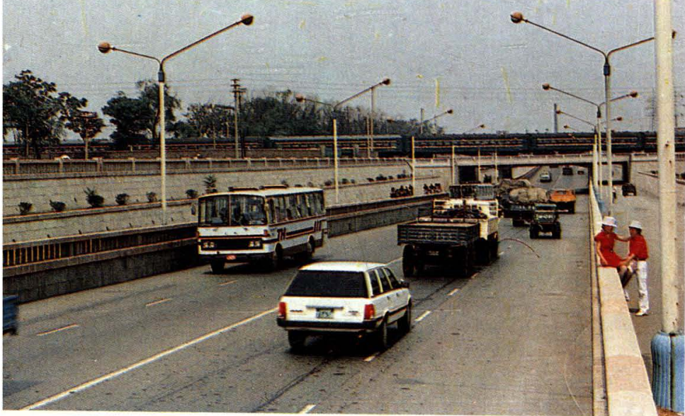
张店东公路与铁路立体交叉
