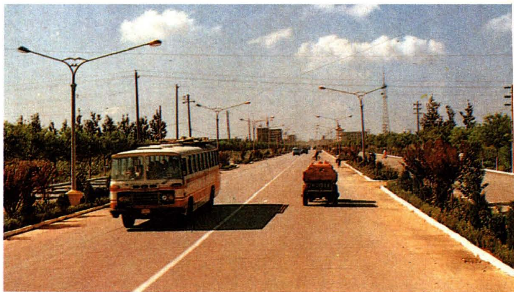
烟台—汕头国道 莱州城区一级路
