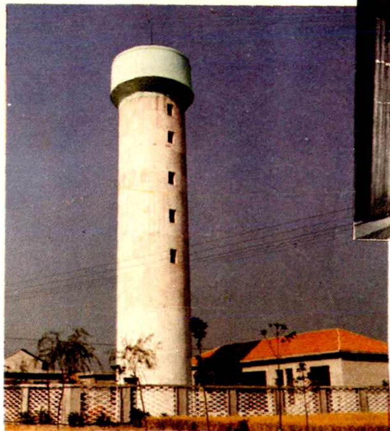
自来水厂水塔
