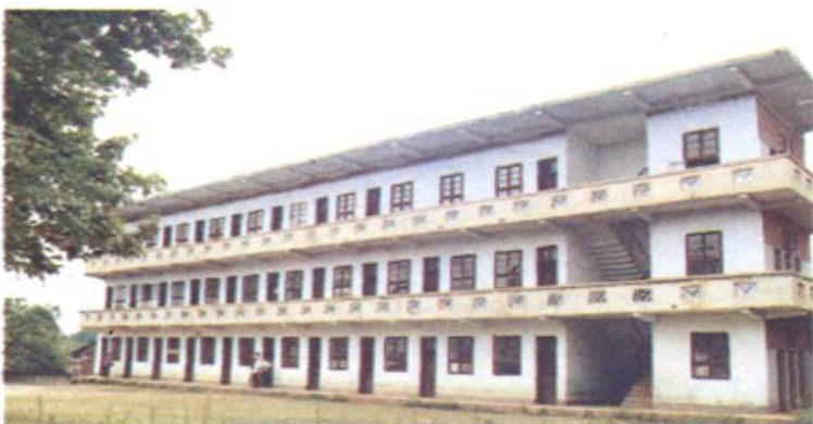
▲ 网岭园林场场部
