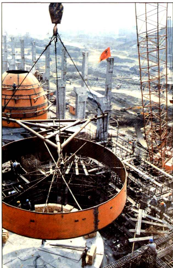
750 立方米高炉正在进行炉体吊装
