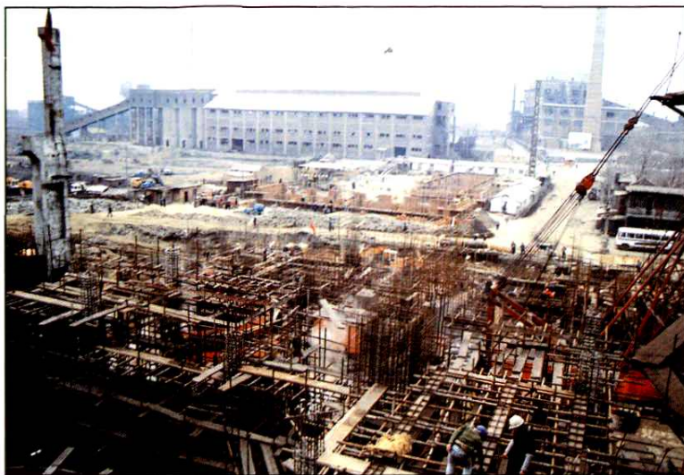
750 立方米高炉建设场景
