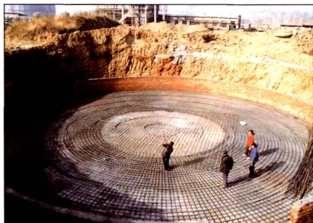
烧结 150 米烟囱基础建设
