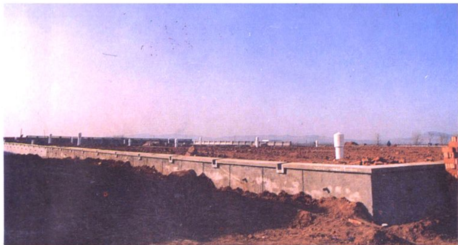
竣工后的贮水池
