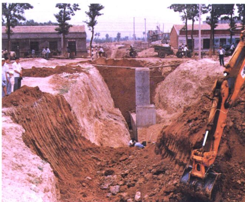
排海管线临淄段施工
