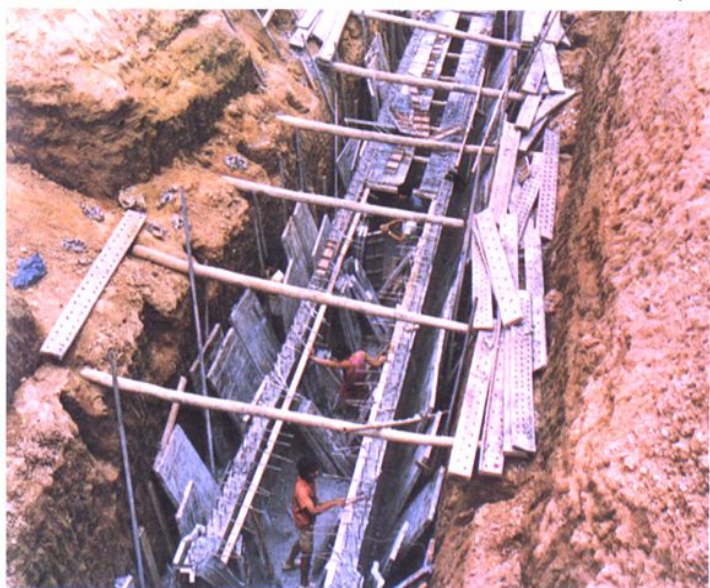
排海管线广饶段施工
