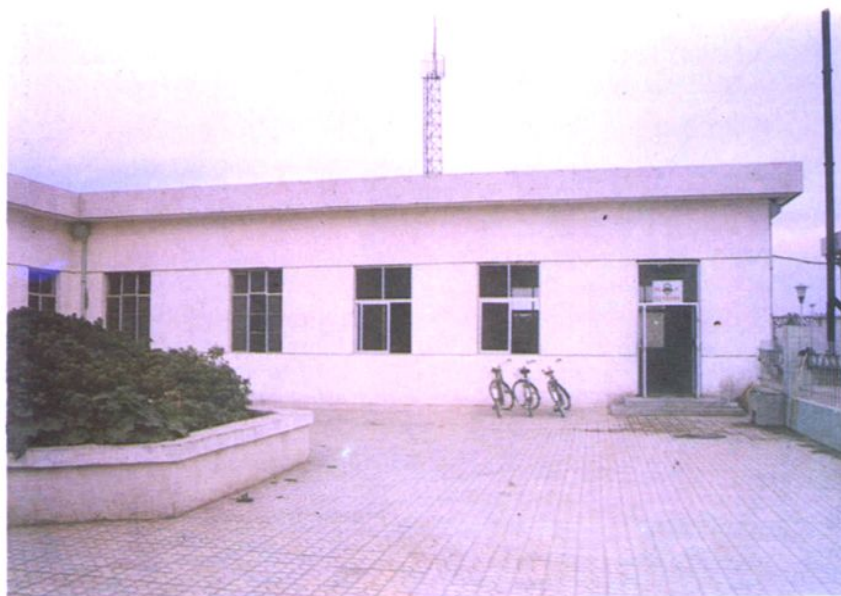
辛店水源管理站
