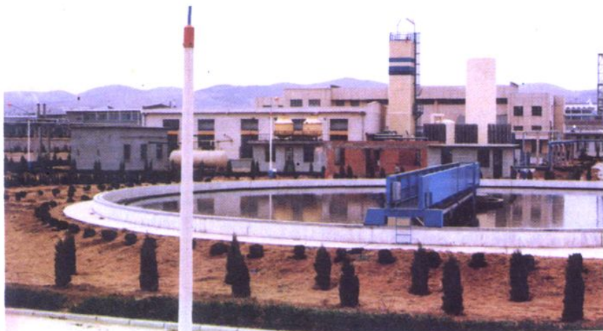
污水处理场小空分装置和沉淀池装置
