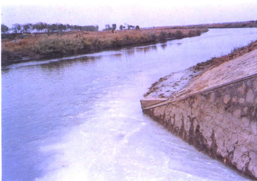
排海管线中污水处理排入小清河入海
