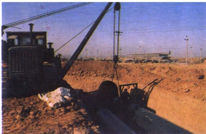
安装输水管线
