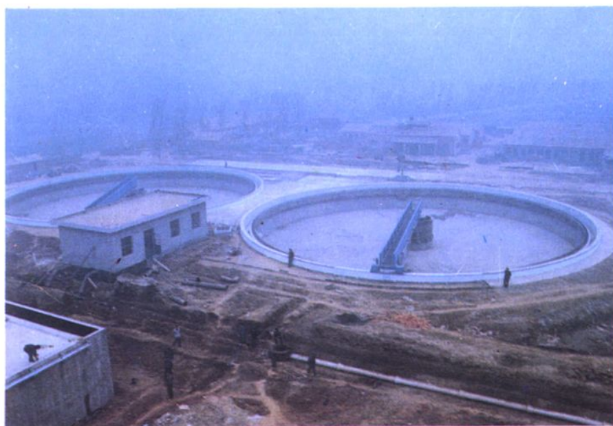
沉淀池施工全貌
