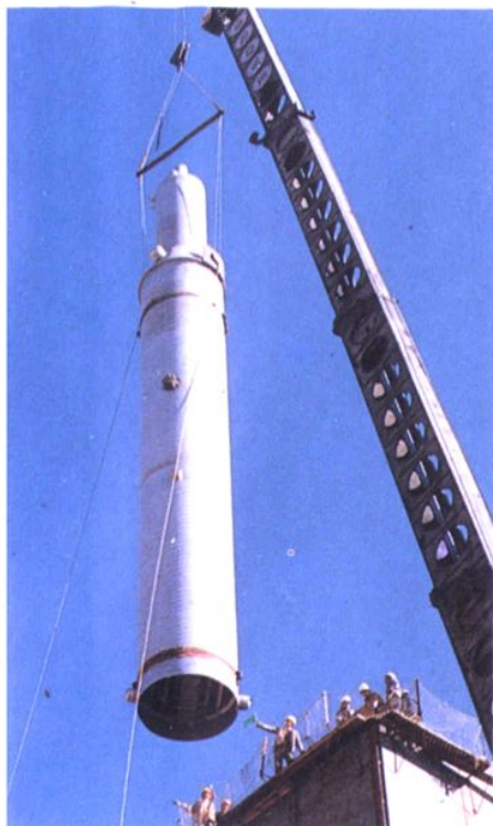
安装6000立方米 空分装置分子筛
