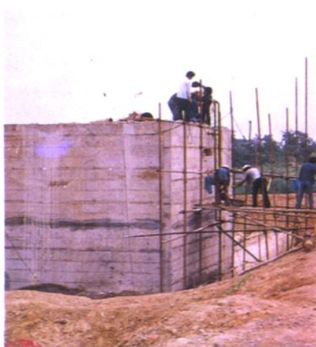
倒虹吸在施工中
