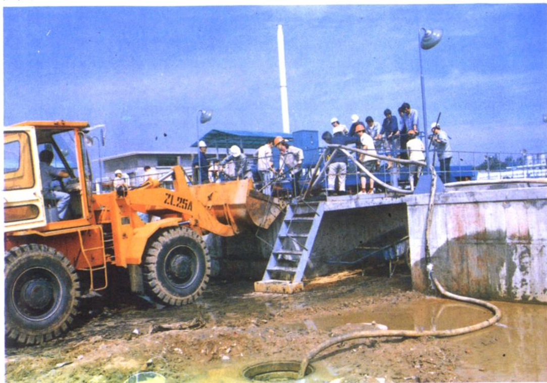
大检修清理污泥
