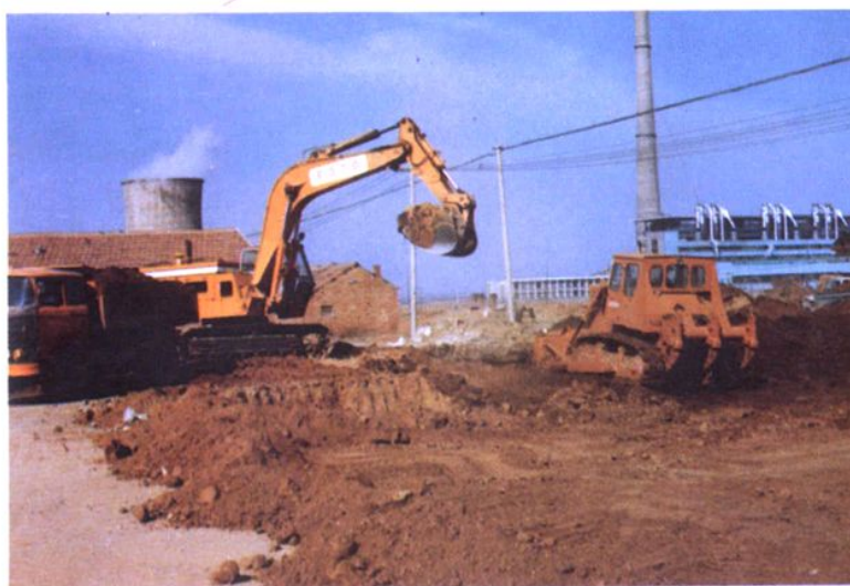
6000立方米空分 装置土建施工
