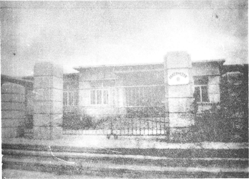
正安中心卫生院门诊（建于1984年）
