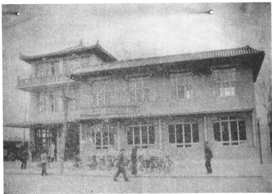
北镇县妇幼保健院（建于1984年）
