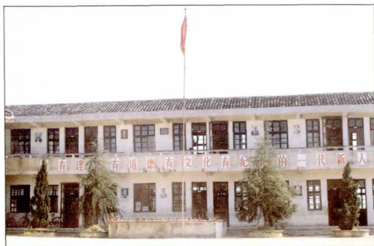
1988年建的练川中心小学教学楼
