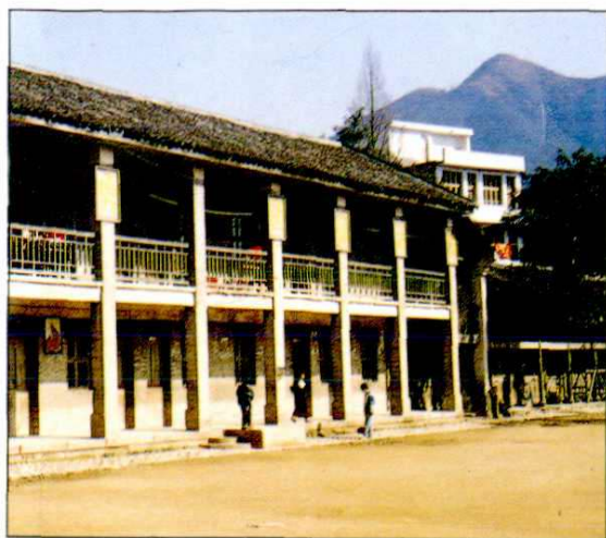
南雁镇中心小学教学楼
