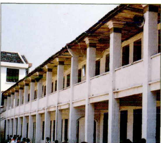
鳌江第一小学教学楼
