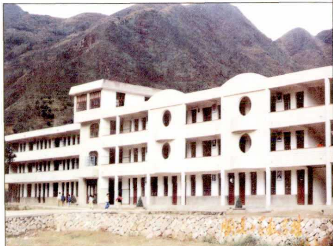
顺溪小学教学楼
