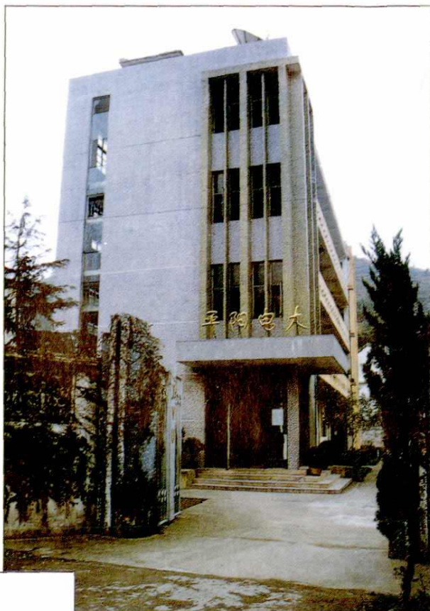
平阳电视大学教学楼
