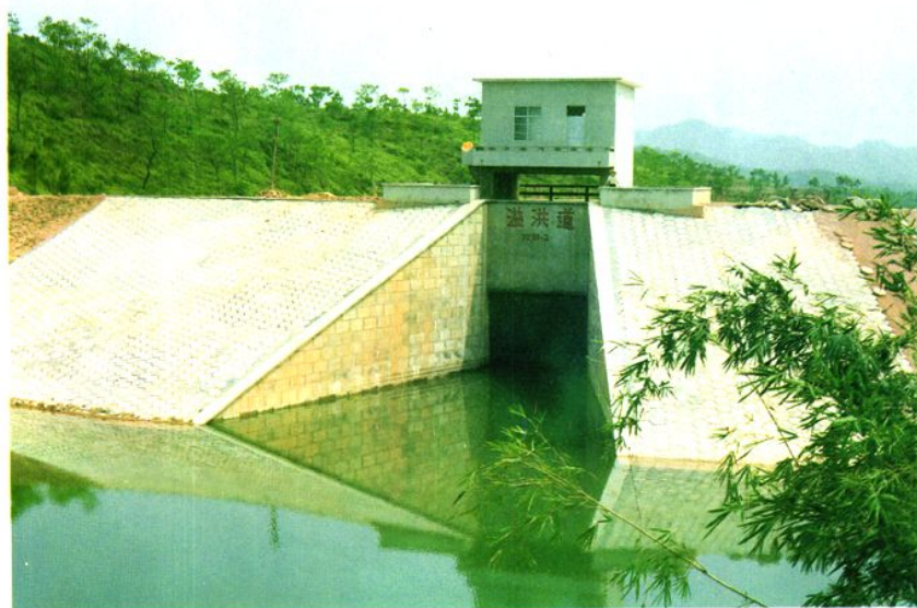
◀ 杨梅水库 首丫塘溢洪道
