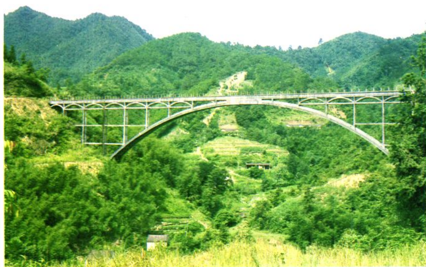
◀ 九坑河水库 二级站双坑渡槽 净跨102米
