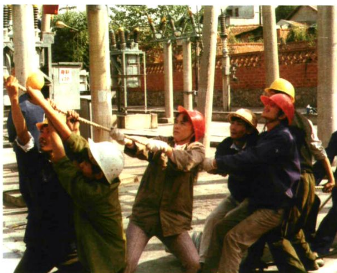
1991年10月，荆门供电局变电工区安装设备
