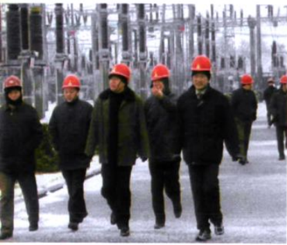
2004年12月，湖北省电力公司副总经理汤文全（中）视察220千伏枣山变电所雪灾灾情
