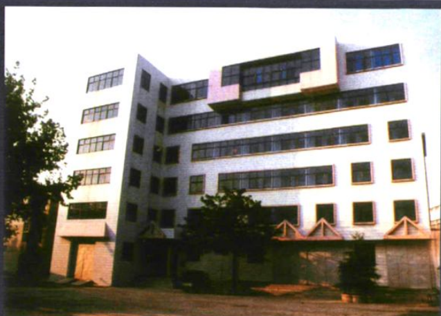
2007年6月，荆门供电公司变电部办公楼
