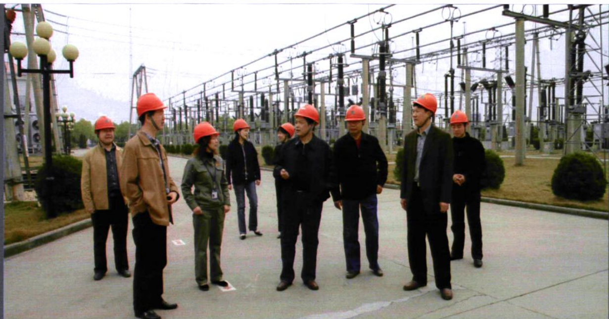
2007年4月，荆门供电公司党委书记王晓刚（右四）调研200千伏枣山变电所
