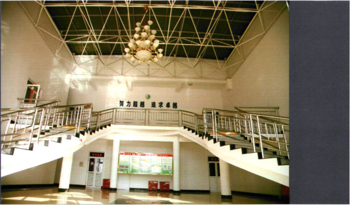
2007年6月，220千伏郢中变电站主控室大厅
