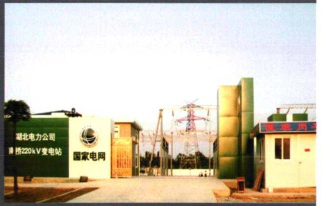
2007年12月，在建的220千伏南桥变电站
