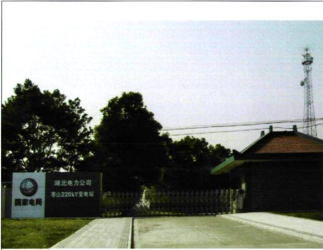
220千伏枣山变电站
