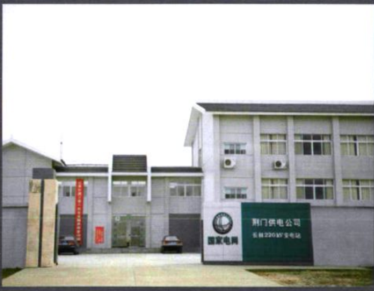
2007年1月，220千伏长林变电站建成投运
