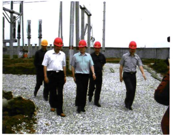
2004年6月，湖北省电力公司总经理王远璋（左三）视察110千伏兴隆岗输变电工程
