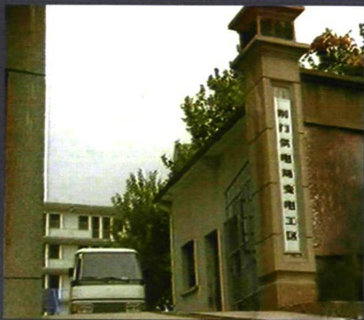
1989年9月，荆门供电局变电工区办公地点
