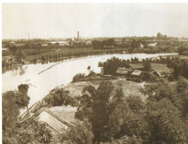
▲ 清末四川机器局新厂远眺（厂址在河对岸） 刘永禄提供
