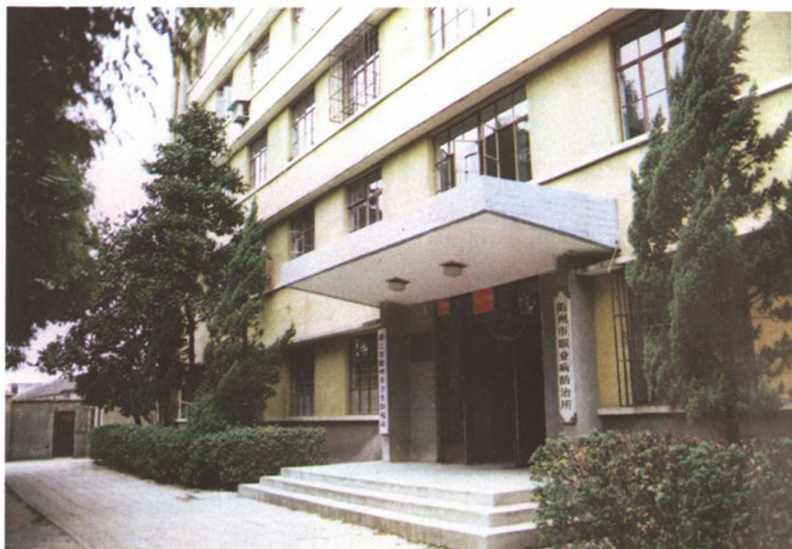
市卫生防疫站办公楼
