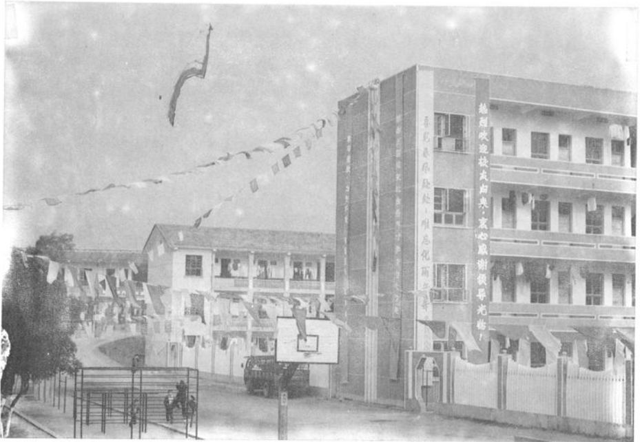
望城县第二中学学生宿舍大楼
